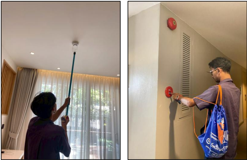
รูปภาพที่ 2.8 การตรวจสอบอุปกรณ์ป้องกันและแจ้งเตือนอัคคีภัย
